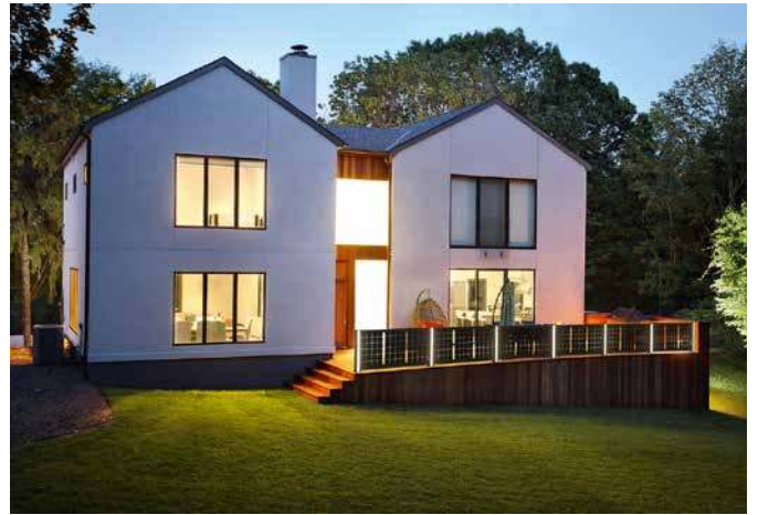
Nicht nur am Balkon, auch als Zaunverkleidung machen die Solarelemente eine gute Figur – und sorgen gleichzeitig für mehr Energie-Unabhängigkeit. (Foto: djd/www.solarcarporte.de)
